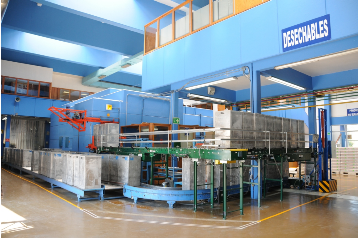
Interior de la Planta de Irradiación Gamma, donde se aprecia el nuevo Transportador de entrada de producto a la cámara de irradiación
